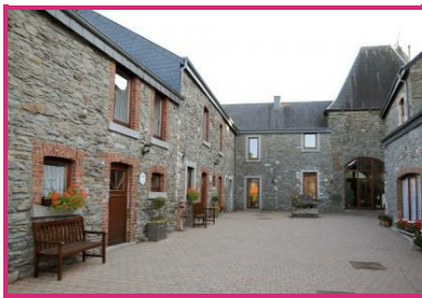
Château-Ferme de Laval
