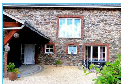
Gîte du Rancourt - Sous la grange
